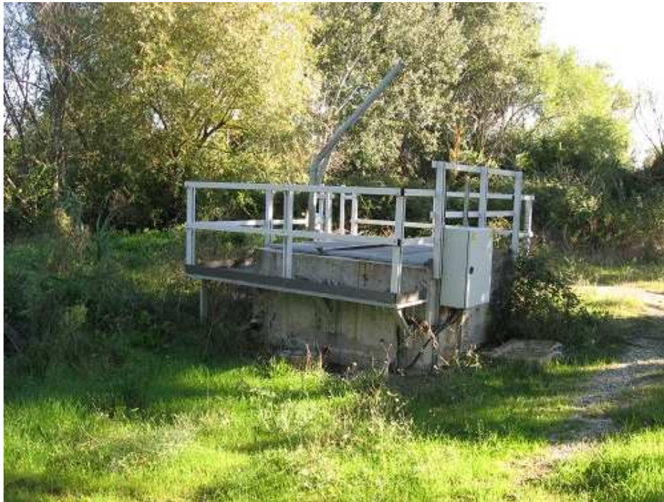
Le by-pass de Pernes les fontaines (Vaucluse)
